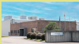
現工場 (中野製薬製造株式会社)
